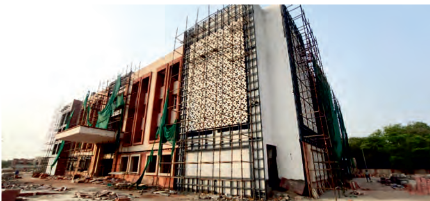
नए कार्यालय भवन का निर्माण कार्य
